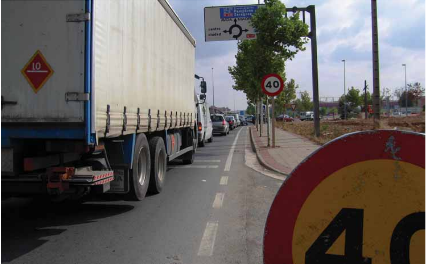
La imprevisión en la ejecución de las obras repercute en el tráfico
